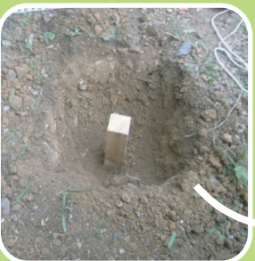
杭を打ち込む
