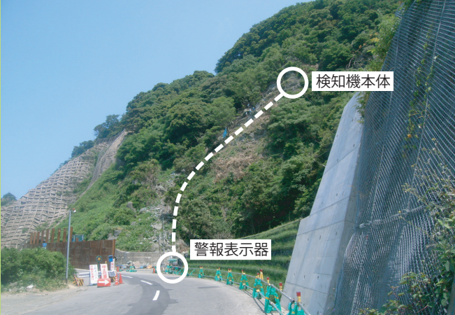
巨大な岩塊の挙動監視のため岩塊脚部に検知器本体を設置し、警報機は道路横の擁壁に設置
