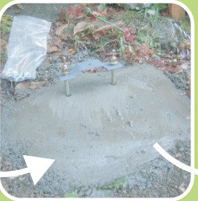
コンクリートで基礎をかためる
